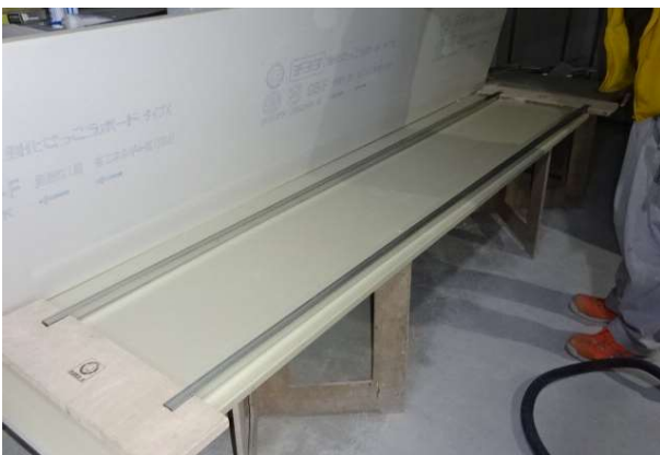
下張り材への補強材留付け方法（一般例）
