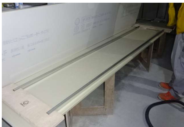
下張り材への補強材留付け方法（一般例）
